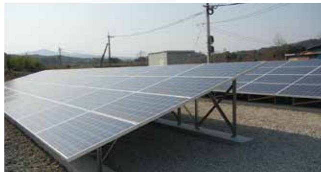
大分県 設置容量:50kW
