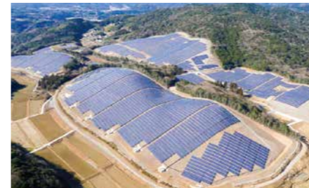
大分県 設置容量:24MW
