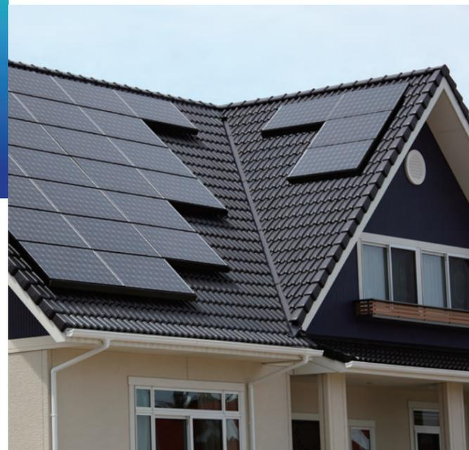
各太陽電池モジュールを組合せて、様々な屋根に設置が可能です。さらに、N型太陽電池モジュールであるQ.TRONシリーズはPERC構造の太陽電池モジュールQ.PEAK DUO-G11Sシリーズと比較して年間最大5.0%多く発電します。
