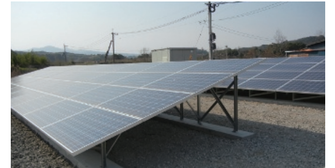
日本・大分県 設置容量: 50kW
