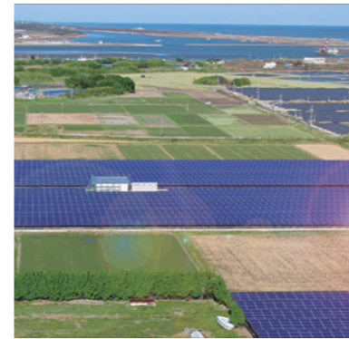
宮崎県 設置容量:2.1MW
