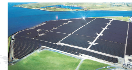
福岡県 設置容量:22.9MW
