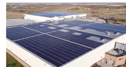
カナダ 設置容量:1.14MW
