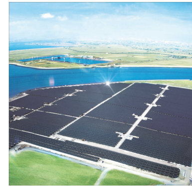
福岡県 設置容量:22.9MW
