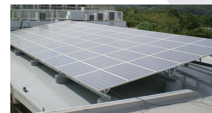
神奈川県 設置容量:17kW
