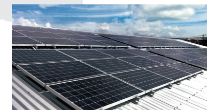
愛知県 設置容量:34.56kW
