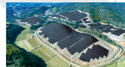
大分県 設置容量:24MW
