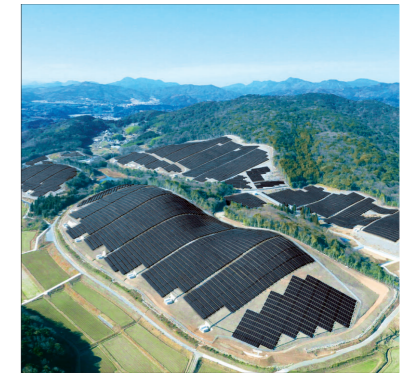
大分県 設置容量:24MW
