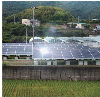
栃木県 設置容量:76.32kW
