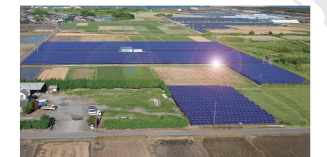
宮崎県 設置容量:2.1MW
