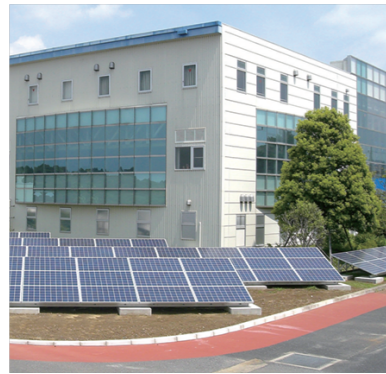
千葉県 設置容量:33kW
