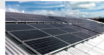
愛知県 設置容量:34.56kW
