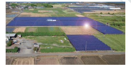
宮崎県 設置容量:2.1MW
