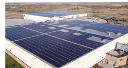
カナダ 設置容量:1.14MW
