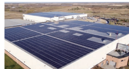
カナダ 設置容量:1.14MW
