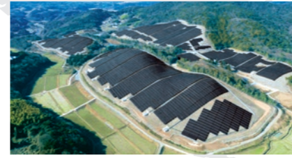
大分県 設置容量:24MW
