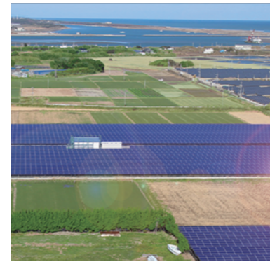
宮崎県 設置容量:2.1MW
