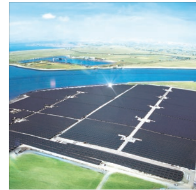
福岡県 設置容量:22.9MW
