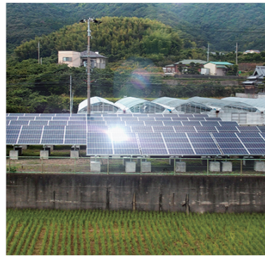
栃木県 設置容量:76.32kW
