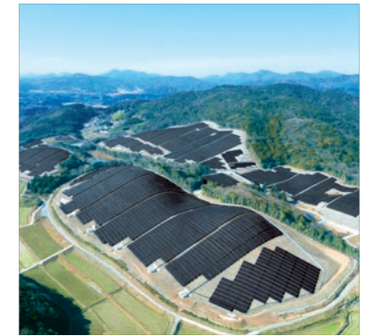
大分県 設置容量:24MW
