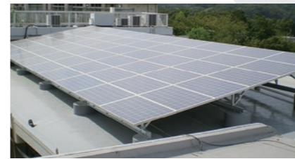
神奈川県 設置容量:17kW
