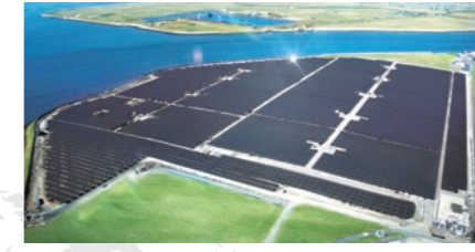
福岡県 設置容量:22.9MW
