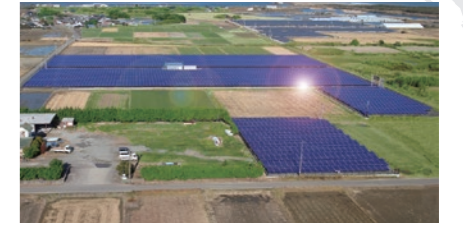
宮崎県 設置容量:2.1MW
