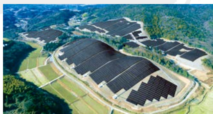
大分県 設置容量:24MW
