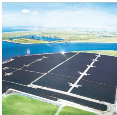
福岡県 設置容量:22.9MW
