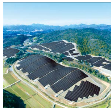
大分県 設置容量:24MW
