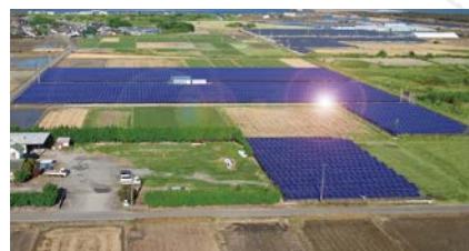
宮崎県 設置容量:2.1MW
