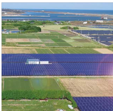
宮崎県 設置容量:2.1MW
